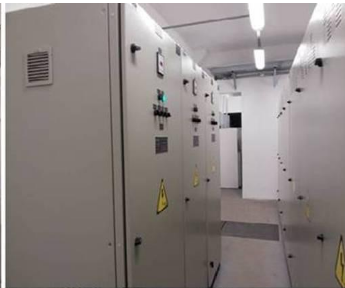
(03) QF de correção de Fator de Potência Automática
